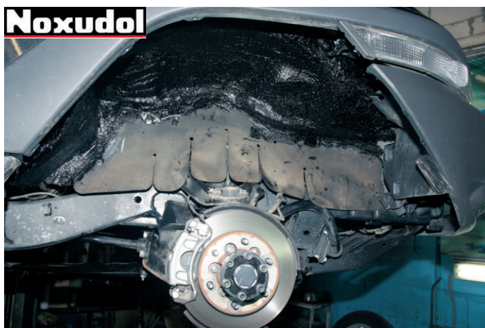
Покрытие Noxudol Autoplaston, нанесенное шпателем и кистью
